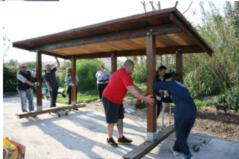
Gruppo di persone impegnate a costruire il riparo del centro della colonia, sotto la protezione di un'ombrello
